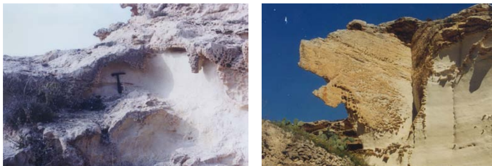
Foto10. Aspecto del encostramiento calcáreo superficial sobre la arenisca limosa. La erosión diferencial resalta esta costra. Foto11. Detalle de la “cabeza del oso”, en el sector oeste de la cantera central
